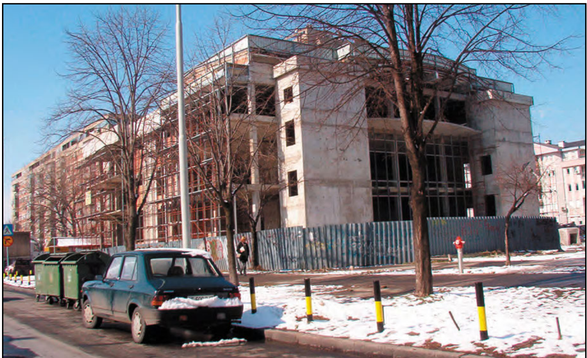
Radovi na univerzitetskoj zgradi u ulici Goce Delčeva br. 8 (1. mart 2006).
