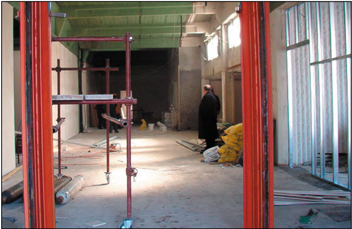
Radovi na univerzitetskoj zgradi u Bulevaru umetnosti br. 29 (1. mart 2006).
